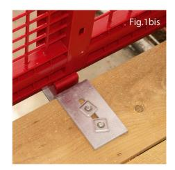
Posa in opera dei tubolari sulle staffe di ancoraggio e dei piantoni sui tubolari (fig. 2 e 2 bis)
