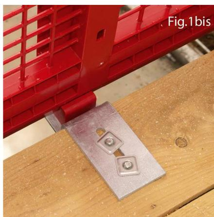
Mise en oeuvre des potelets sur les étriers d'ancrage et des fourreaux sur les potelets (fig. 2 et 2 bis)
