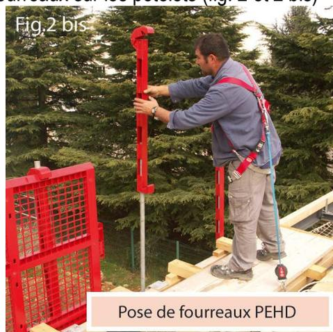
La mise en oeuvre des garde-corps sur les fourreaux est réalisée grâce à la configuration particulière de ceux-ci (queue d'aronde). En premier lieu il faut engager la partie basse de la protection, et placer le garde-corps verticalement en l'appuyant contre les fourreaux et en faisant coulisser l'ensemble vers le bas. Une fois placé, le garde-corps ne peut plus être démonté de son support (fig. 3 et 3 bis).
